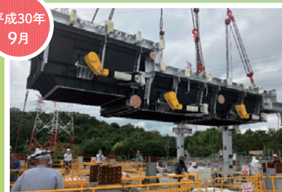
焼却炉組立工事
