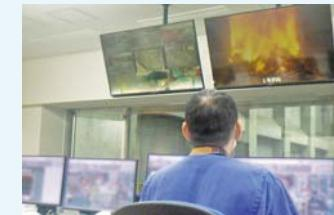
モニターに映し出される焼却炉内でごみが燃えている様子と、パソコン画面に表示される排ガス成分の変動を常に意識して監視しています。
